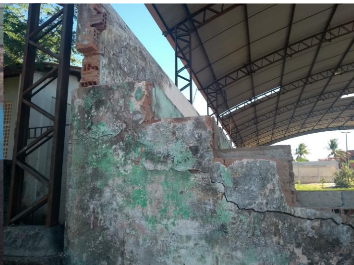
Imagem 26 – Foto tirada in loco da arquibancada e da estrutura metálica da quadra. Fonte: COPROJ-SEINF.
