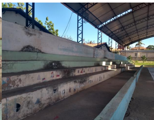
Imagem 28 – Foto tirada in loco da arquibancada e da estrutura metálica da quadra. Fonte: COPROJ-SEINF.
