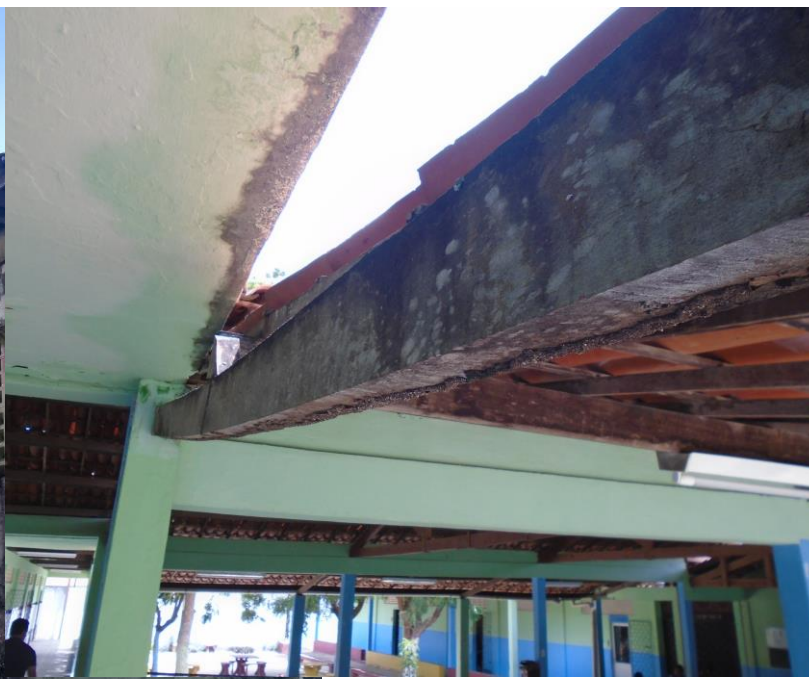
Imagem 07 – Foto tirada in loco do madeiramento da coberta. Fonte: COPROJ-SEINF.
