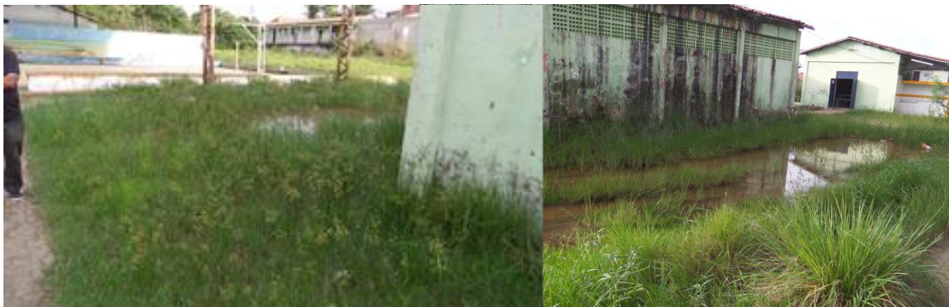
Imagem 21 – Foto tirada in loco da lateral do auditório. Fonte: COPROJ-SEINF
