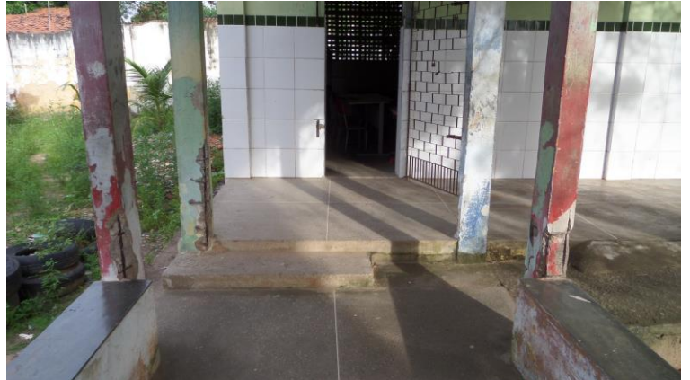
Imagem 11 – Foto tirada in loco dos pilares. Fonte: COPROJ-SEINF.
