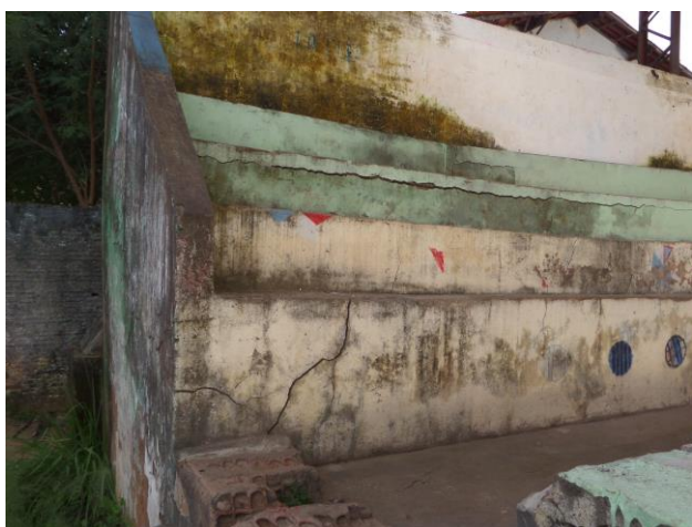
Imagem 27 – Foto tirada in loco da arquibancada. Fonte: COPROJ-SEINF.
