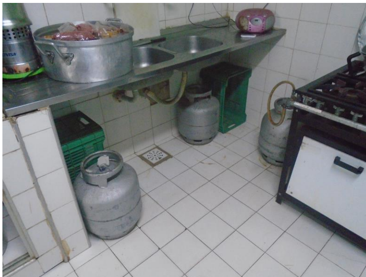
Imagem 16 – Foto tirada in loco da cozinha. Fonte: COPROJ-SEINF.
