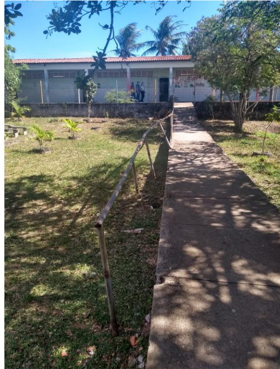
Imagem 07 – Foto tirada in loco da rampa de acesso às salas do nível superior. Fonte: COPROJ-SEINF.
