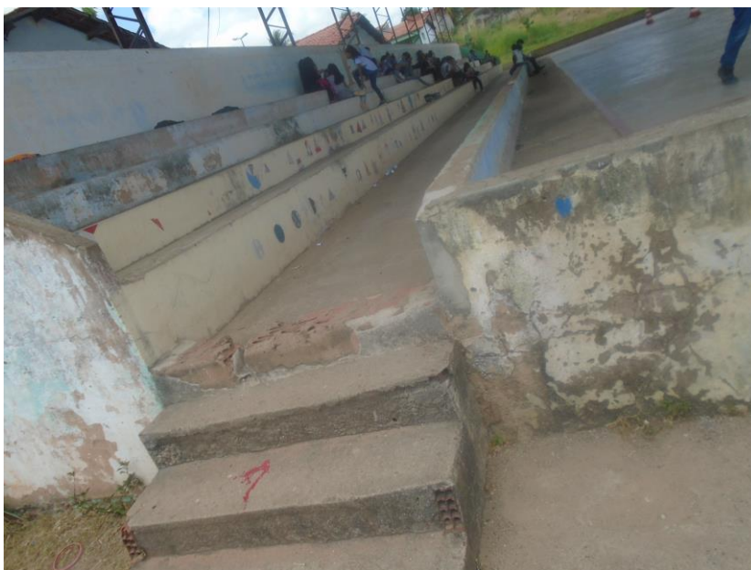
Imagem 08 – Foto tirada in loco do acesso à quadra. Fonte: COPROJ- SEINF.
