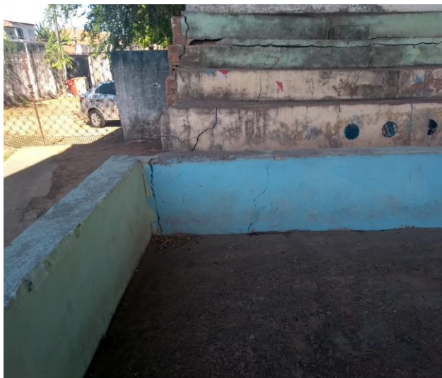
Imagem 25 – Foto tirada in loco da arquibancada. Fonte: COPROJ-SEINF.
