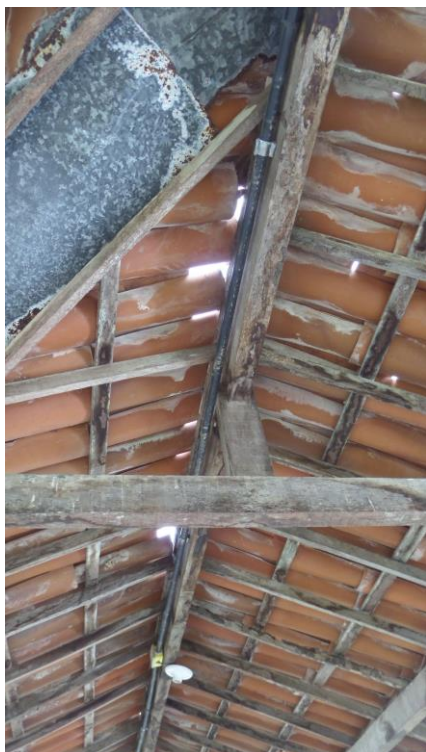
Imagem 37 – Imagem do madeiramento e cobertura atual. Fonte: COPROJ-SEINF.
