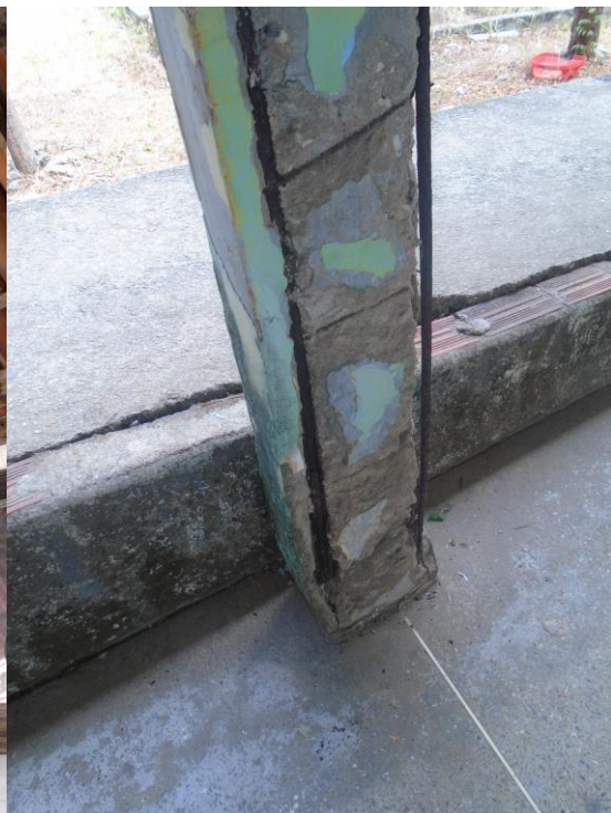
Imagem 13 – Foto tirada in loco dos pilares. Fonte: COPROJ-SEINF.
