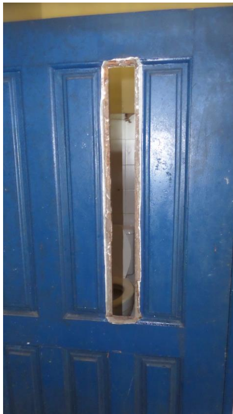
Imagem 14 – Foto tirada in loco em um dos banheiros. Fonte: COPROJ-SEINF.
