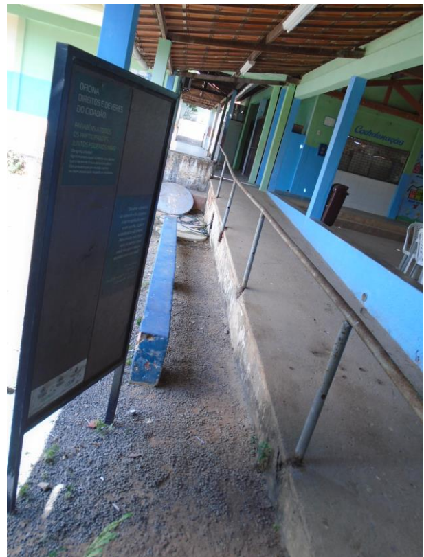
Imagem 05 – Foto tirada in loco da rampa de acesso às salas. Fonte: COPROJ-SEINF.
