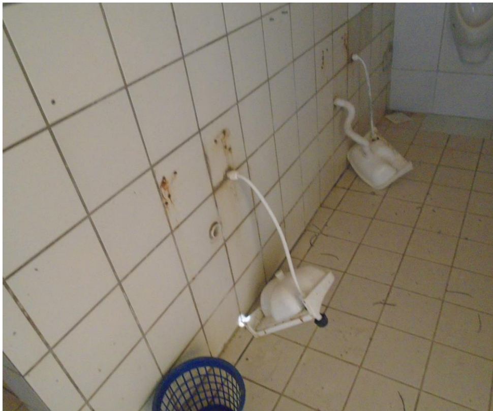
Imagem 15 – Foto tirada in loco em um dos banheiros. Fonte: COPROJ-SEINF.
