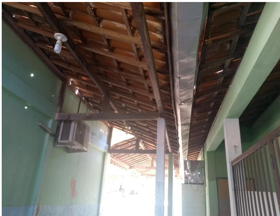
Imagem 38 – Imagem do madeiramento e cobertura atual. Fonte: COPROJ-SEINF.
