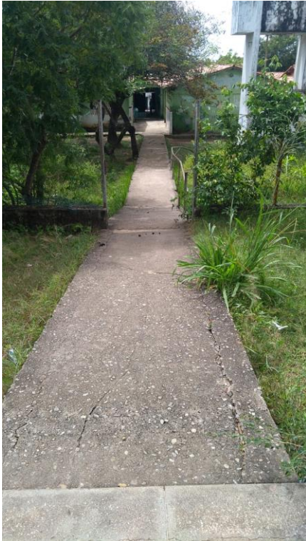
Imagem 06 – Foto tirada in loco da rampa de acesso às salas do nível superior. Fonte: COPROJ-SEINF.
