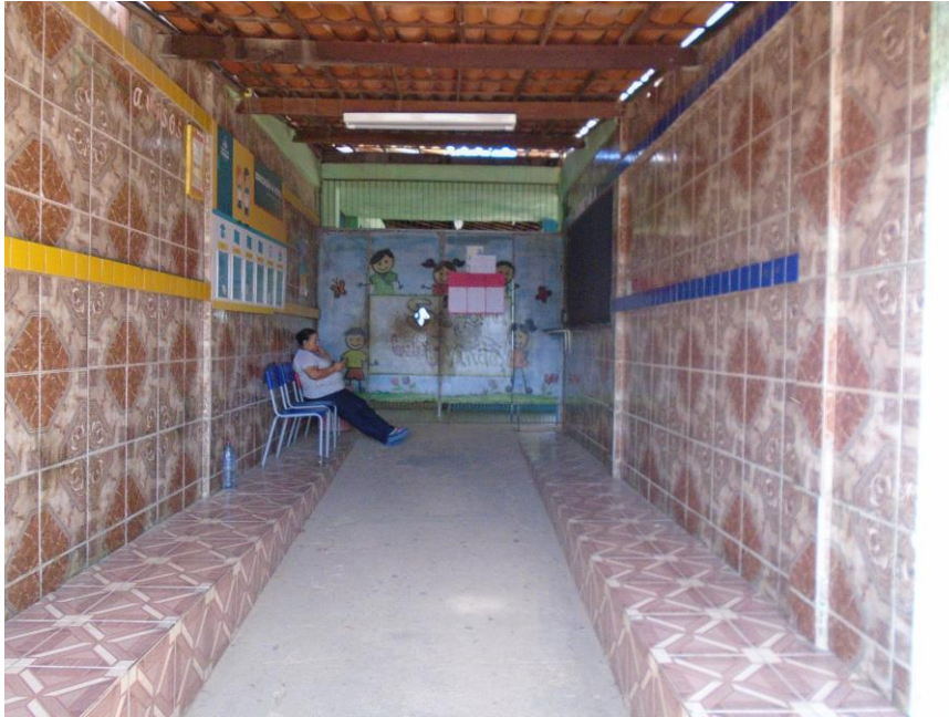
Imagem 03 – Foto tirada in loco do desnível para entrada da área interna da escola. Fonte: COPROJ- SEINF.
