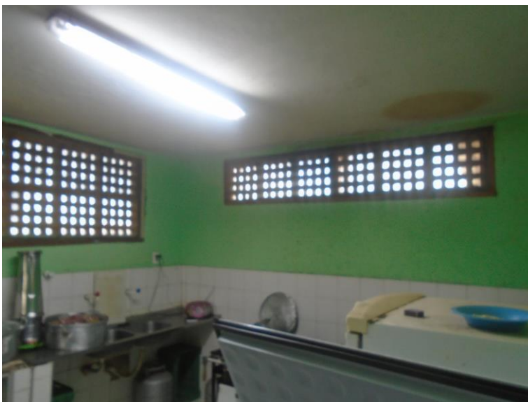
Imagem 17 – Foto tirada in loco da cozinha. Fonte: COPROJ-SEINF.
