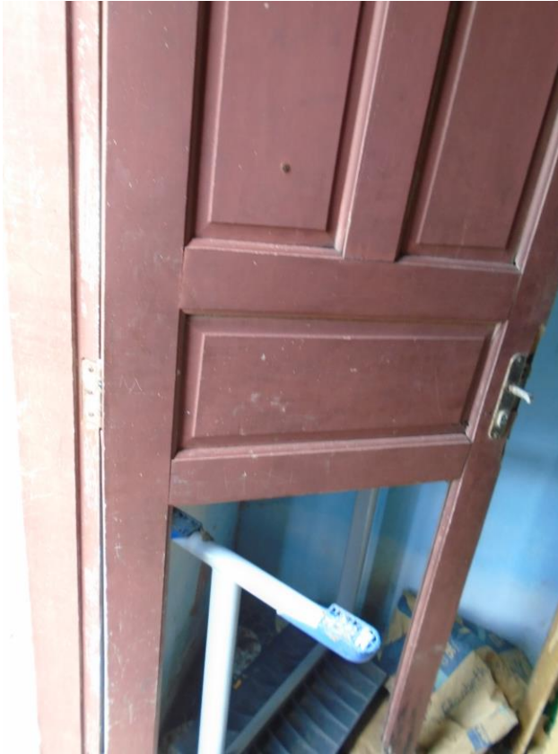
Imagem 18 – Foto tirada in loco da porta de madeira. Fonte: COPROJ-SEINF.
